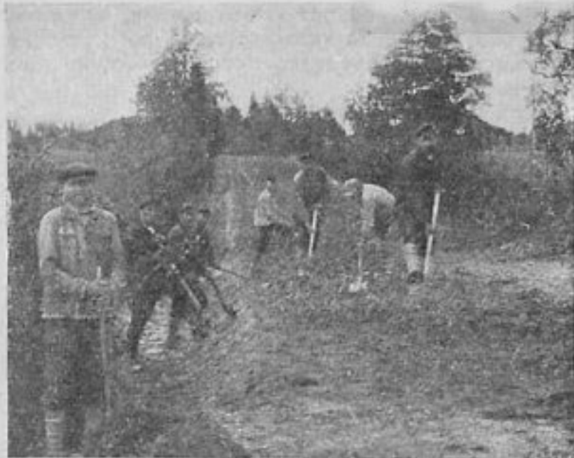
Капитальный ремонт полотна дороги на 25 км от Великих Лук на Поречье (Ленингр. губ.)
