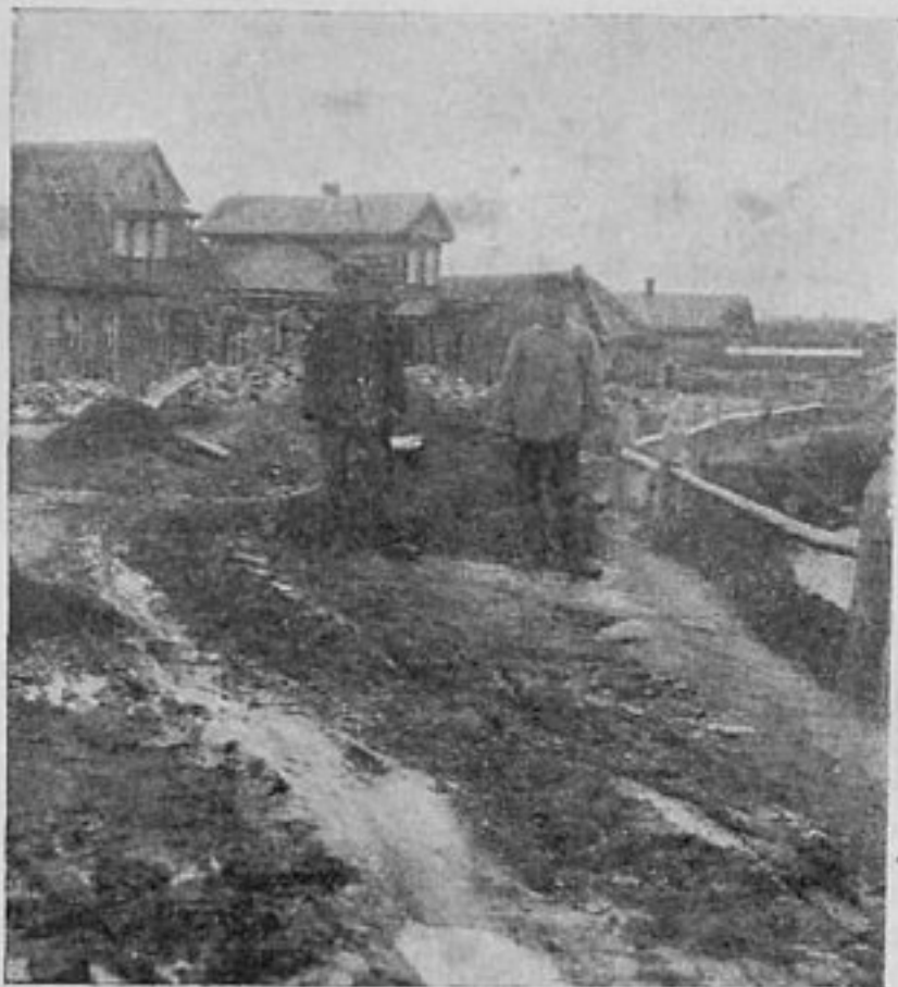
Дорога, подготовляемая к замощению в порядке трудповинности
